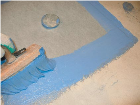
Rys. 11 Wykonanie uszczelnienia wpustu podłogowego.
